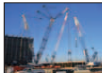
2250 Max-ER Hoisting HRSG's
