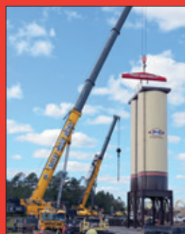
450 Ton and 110 Ton Erecting Silos
