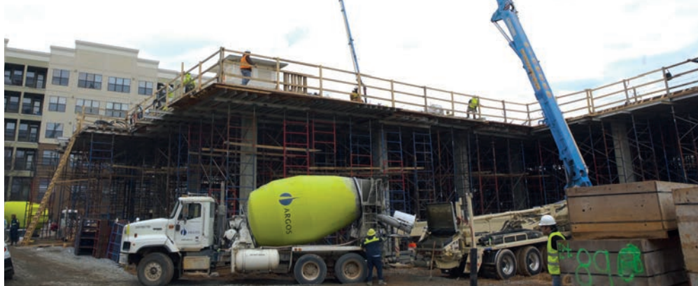
Aqui, o CO 2 já misturado ao concreto da Argos é utilizado na construção de um edifício.
