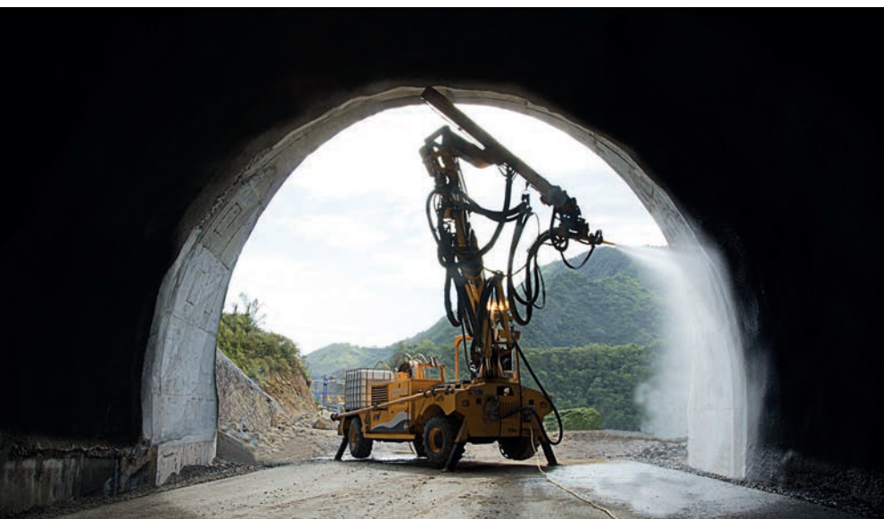
Um equipamento Putzmeister SPM 500 Wetkret trabalhando na Colômbia.
