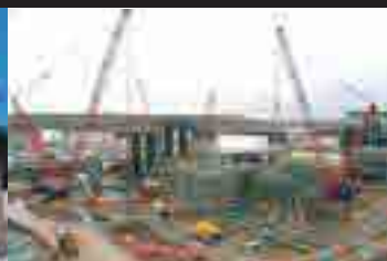
Demag - CC 4000 Cap. 500 ton
